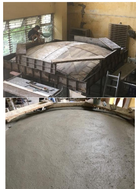
b) Make the mold and pour concrete
